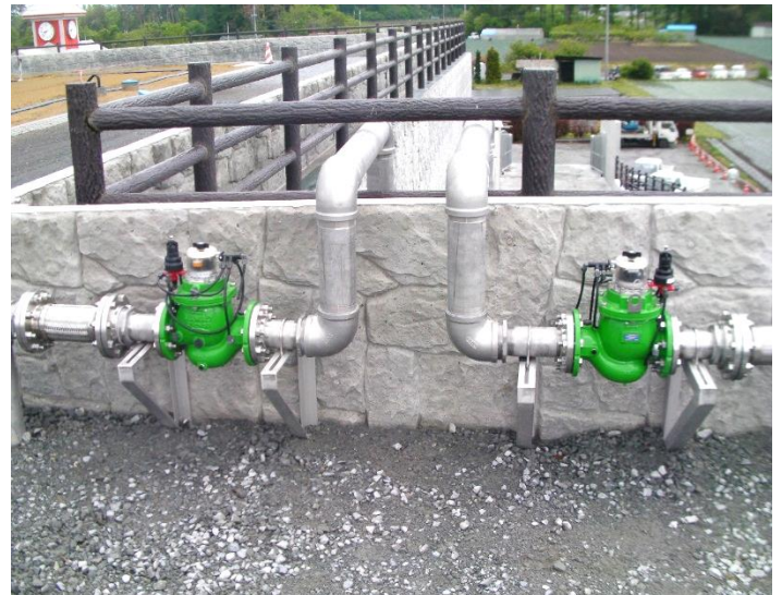
▲ 減圧機能付メタリングバルブ 制御はメタリングバルブで行っています!!
